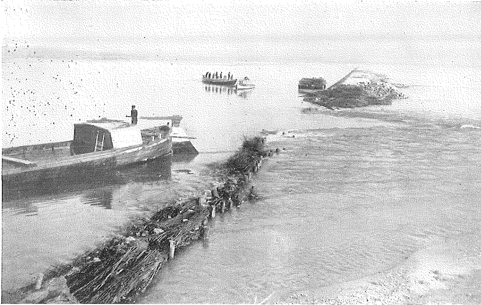
Fig. 19 VISTA, ALL'INIZIO DEI LAVORI, DELLA ROTTA, SULLA DIFESA DI SPONDA ALLA CURVA N. 46 DI OLZA, PROVOCATA DALLA PIENA DEL 1951
