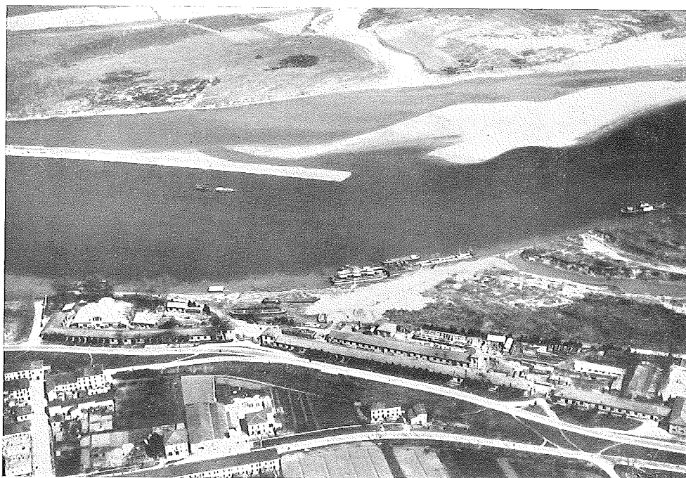
Fig. 29 VEDUTA AEREA DEL CANTIERE DI BORETTO, DI FRONTE ALL'ESTREMO A VALLE DELLA CURVA DI NAVIGAZIONE N. 23 DI VIADANA. SONO EVIDENTI I CAPPANNONI DEL CANTIERE, CORRENTI LUNGO TUTTO L'ARGINE MAESTRO
