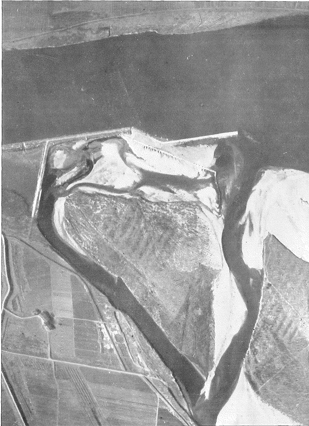
Fig. 8 VEDUTA AEREA DELLE OPERE SECONDARIE COSTRUITE ALL'ESTREMO A VALLE DELLA CURVA N. 28 DI SACCA, PER CHIUDERE I RAMI SECONDARI RITORNATI A TERGO DELL'OPERA
