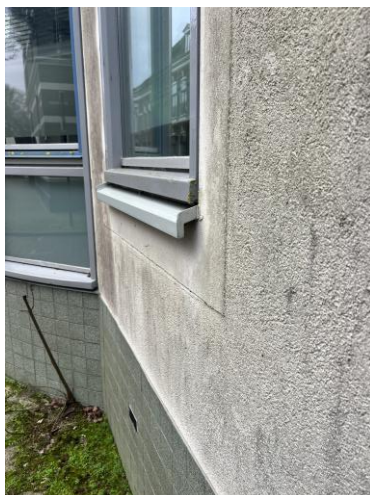
30: De toevoeging van een extra aluminium lekdorpel onder het bestaande houten kozijn. Eigen afbeelding, 2025.
