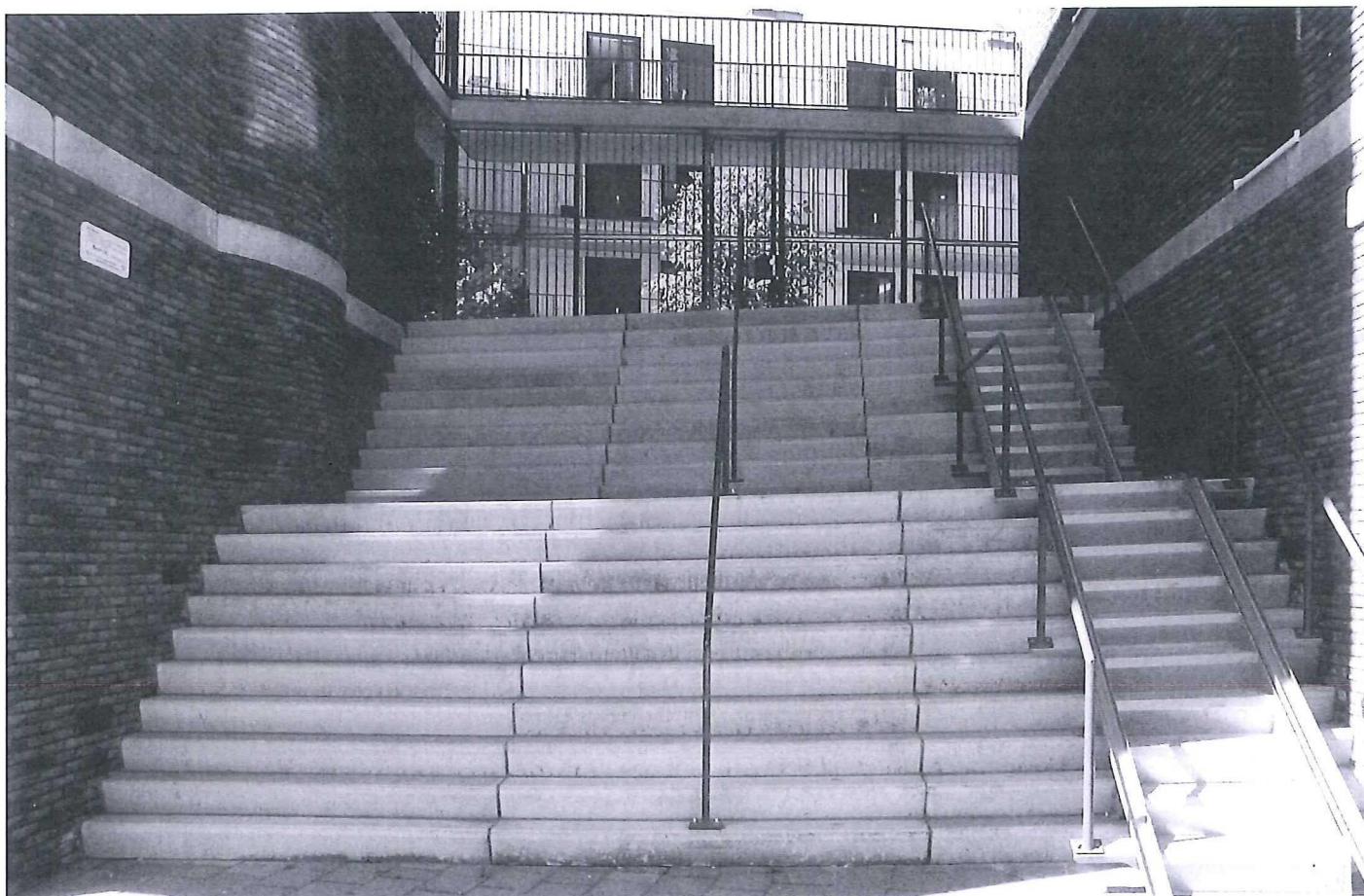
Lang niet alle nieuwbouwappartementen zijn makkelijk toegankelijk.
