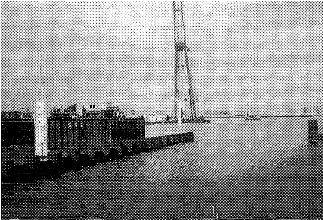
• Figuur 3-55 Afzinken tunnel-element voor de Piet-Heintunnel
