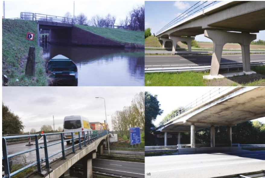
Figure 1. Overview of tested bridges: (a) Halvemaans Bridge; (b) Viaduct Zijlweg; (c) Viaduct Vlijmen Oost; (d) Viaduct de Beek.
