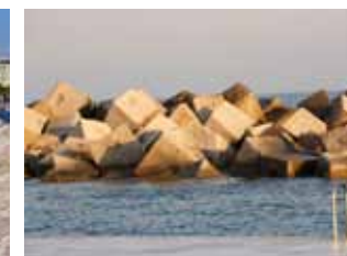
Stenen / blokken voor harde wand
