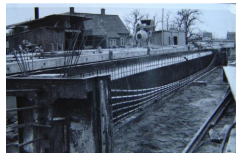
Figuur 7 Aanbrengen voerspankabels voor stort
