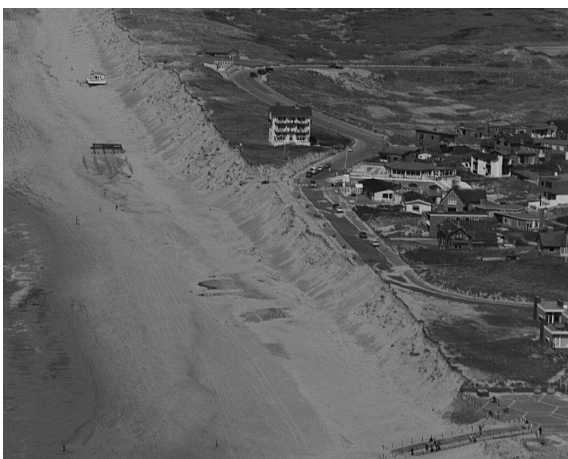
Photo 2.1 Eroded dunefront at Bergen aan Zee after severe storms in the 1980's (photo taken in 1990, www.BeeldbankVenW.nl , Rijkswaterstaat).
