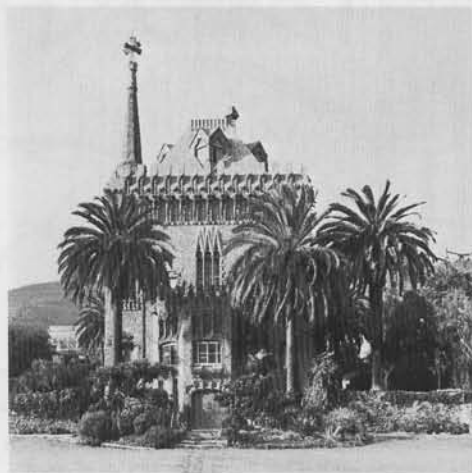
Bellesguard. De zuid-gevel.
