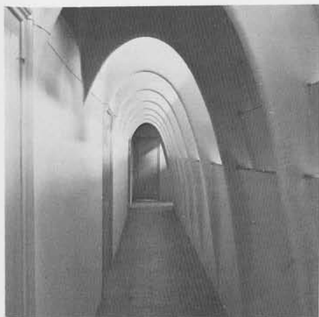
Parabolische diafragma boogjes in de gang rond de lichtschacht op de zesde verdieping.
