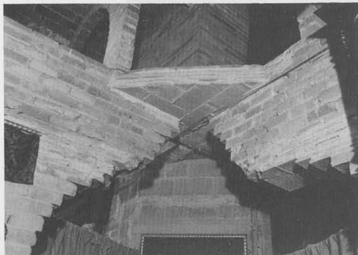
De constructie ter plaatse van de entree tot de desván.
