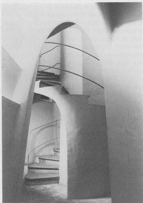
De trap naar het dak op de zesde verdieping, gezien vanuit de gang met de diafragmaboogjes.
