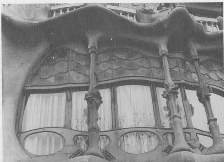
De erker aan de voor- gevel.
