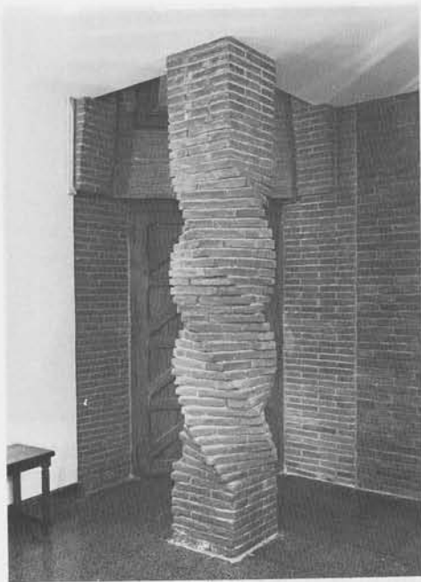
Getordeerde kolom bij de achteringang. Een raam boven de 'dichte' deur verlicht het driehoekige portaal tussen deur en kolom.
