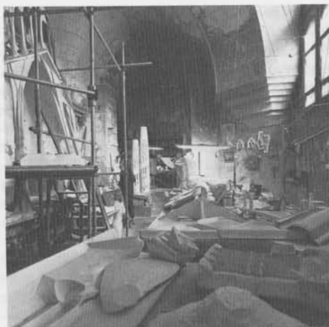
Sagrada Família. Modellen-werkplaats. Nog steeds wordt vrijwel alles in modelvorm ontwikkeld en pas daarna uitgetekend.
