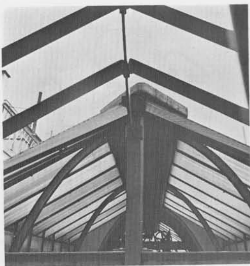
Lichtschacht. De portalen in de glazen kap.
