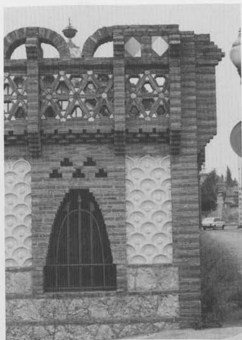
Parabolische raamopening in de voorgevel van de stallen.
