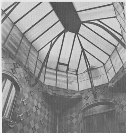
Lichtschacht. De glazen kap met de brede, begaanbare nokbalk. Door het glas heen zichtbaar de schotten tussen de boogjes aan de gang op de zesde verdieping. In de hoek een hemelwaterafvoer.
