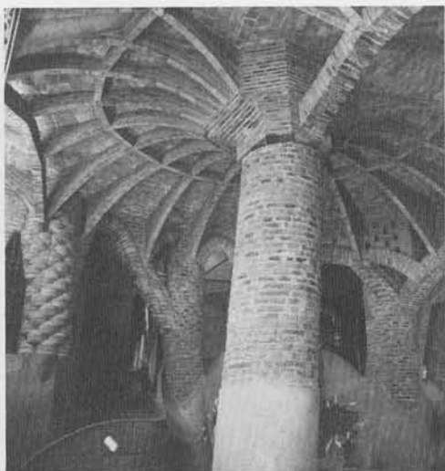
Plafondconstructie van het linker-einde van de hoefijzervormige beuken.
