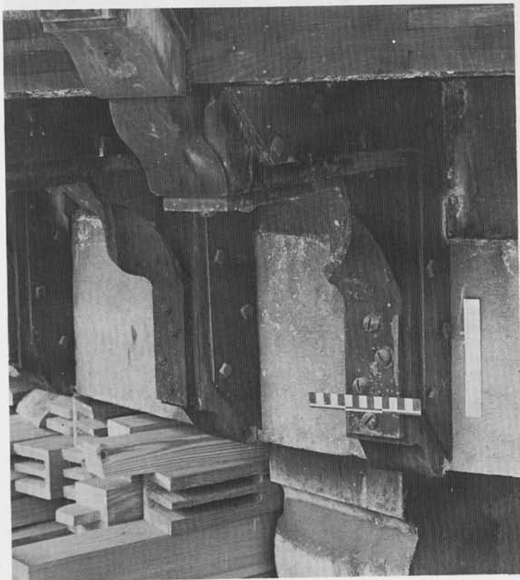
Getordeerde ijzeren strippen gebruikt als hoekverstijvers voor de consoles. De maatstrookjes heb- ben een lengte van 15 cm.
