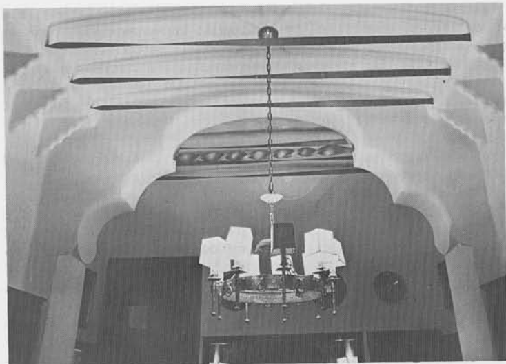
Getordeerde trekstangen in het woonvertrek van de eerste woonlaag.
