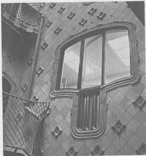
Lichtschacht. Raam met daaronder een door drie lamellen af te sluiten ventilatieopening.
