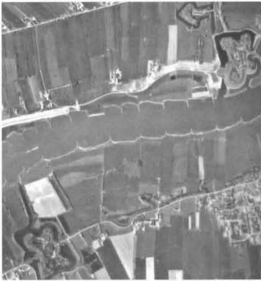
Kruising van de Nieuwe Hollandse Waterlinie met de Lek, gemarkeerd door de forten Honswijk en Everdingen bron: Topografische Dienst
