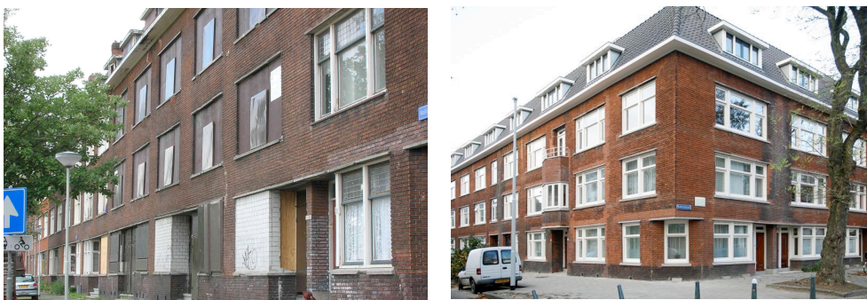
Figuur 4.13: De geveluitstraling is compleet veranderd door de opknapbeurt van het klusproject. Het Wallisblok is erg introvert en vormt een groot blok in de wijk. (flickr.com en bamwoningbouw.nl)
