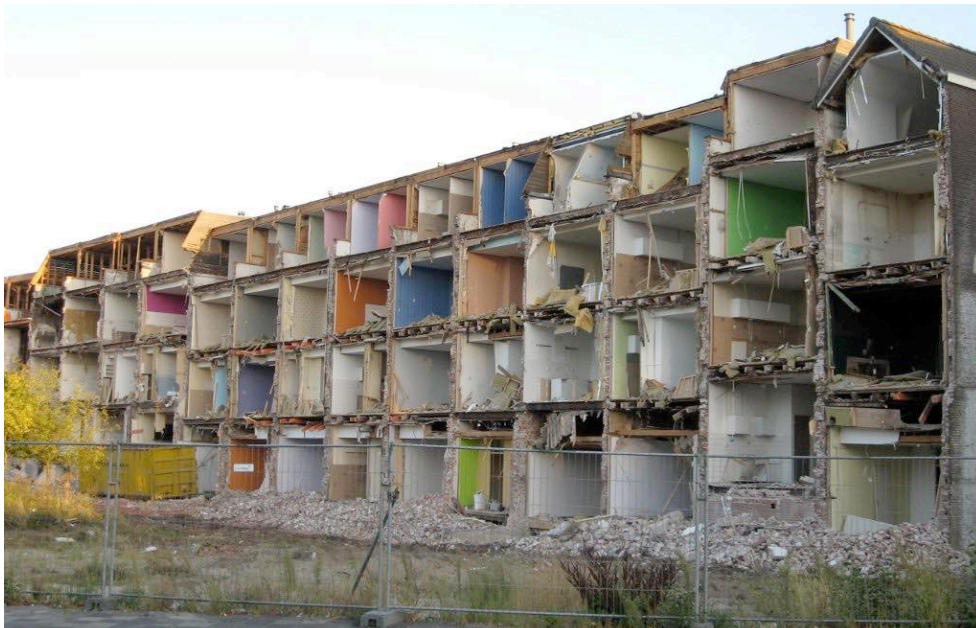
Figuur 4.7: Het klusproject tijdens de eerste bouwfase (driehoekkatendrecht.nl)
