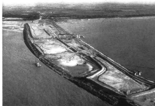
64. Opbouw van het damlichaam door het noordelijke sluitgat van de Grevelingen
