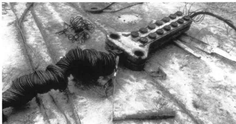
65. De kabelklem na het ongeval. Links de opgestroopte buitenmantel van de kabel, rechts de afgestroopte kern
