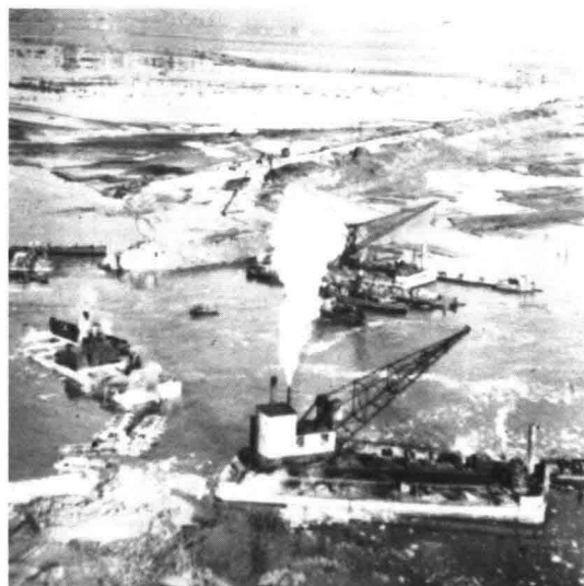
30. Het sluitgat bij Rammekens tijdens de werkzaamheden
