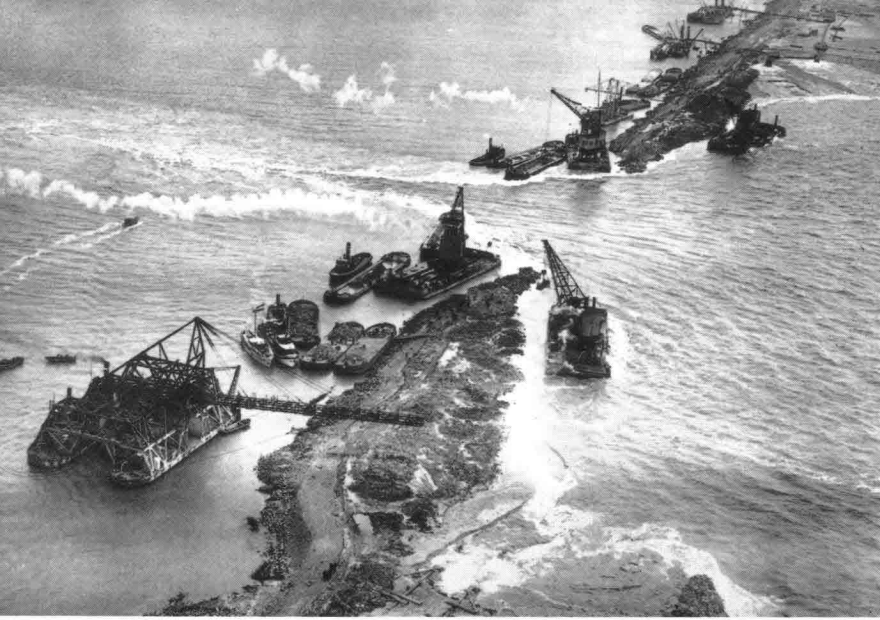
18. Afsluitdijk Zuiderzee. Sluitgat Middelgronden, twee dagen voor de sluiting
