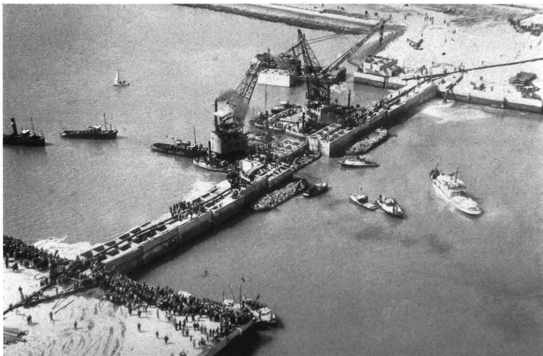
40. De laatste caissons in de Zandkreek worden afgezonken
