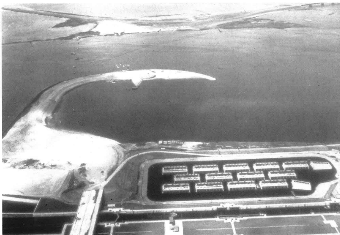
71. De doorlaatcaissons voor de afsluiting van het Volkerak in het geï- nundeerde bouwdoek. Op de achtergrond het toekomstig sluitgat en de Haringvlietbrug
