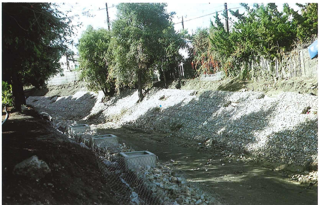
Figs. 24, 25, 26 U.S.A. - California Pour favoriser la pousse de la végétation sur les revêtements en matelas Reno la structure a été comblée par la terre contenant des essences végétales à croissance rapide. En outre, dans la consolidation effectuée par les gabions, des bacs à fleurs ont été spécialement conçus pour accueillir les diverses plantations.
