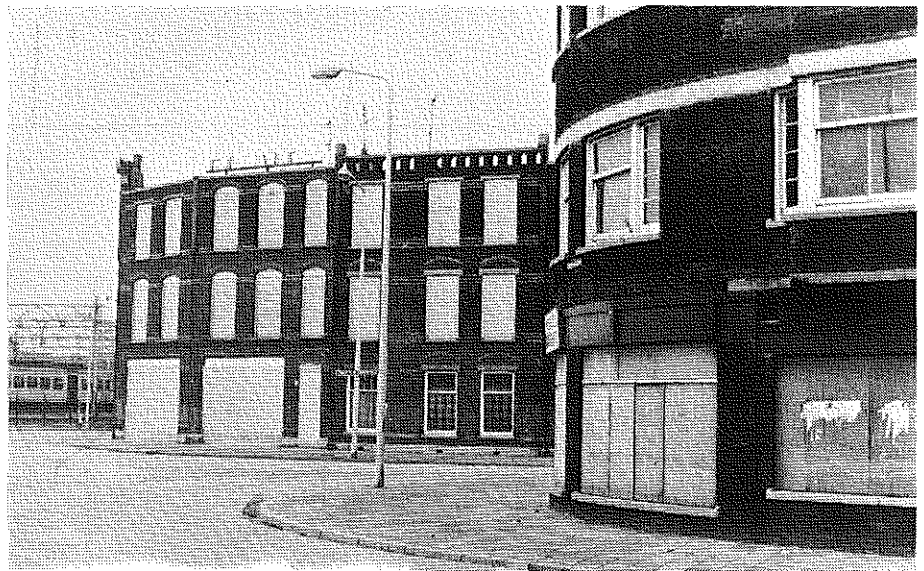
Dichtgespijkerde huizen in het directe toegangsgebied.
