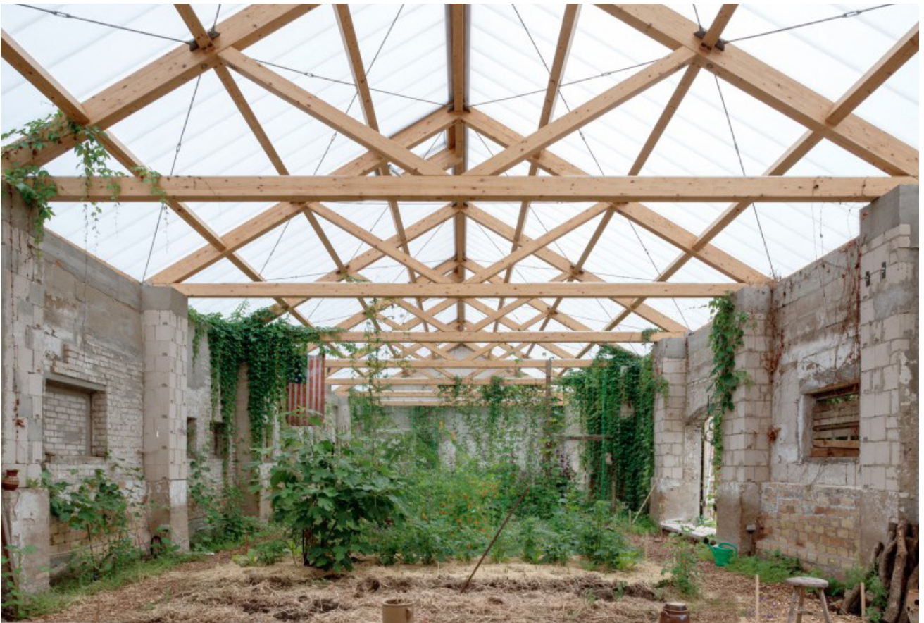
Gutshof Güldenhof, Stechlin, 2020 Heim Balp Architekten
