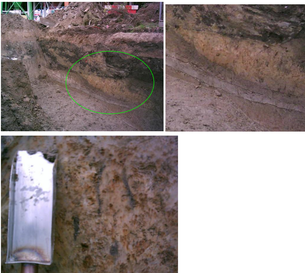
Figuur 7.3 Foto's kleilaag, ontgraving bouwplaats Masiusplein, Zevenaar.
