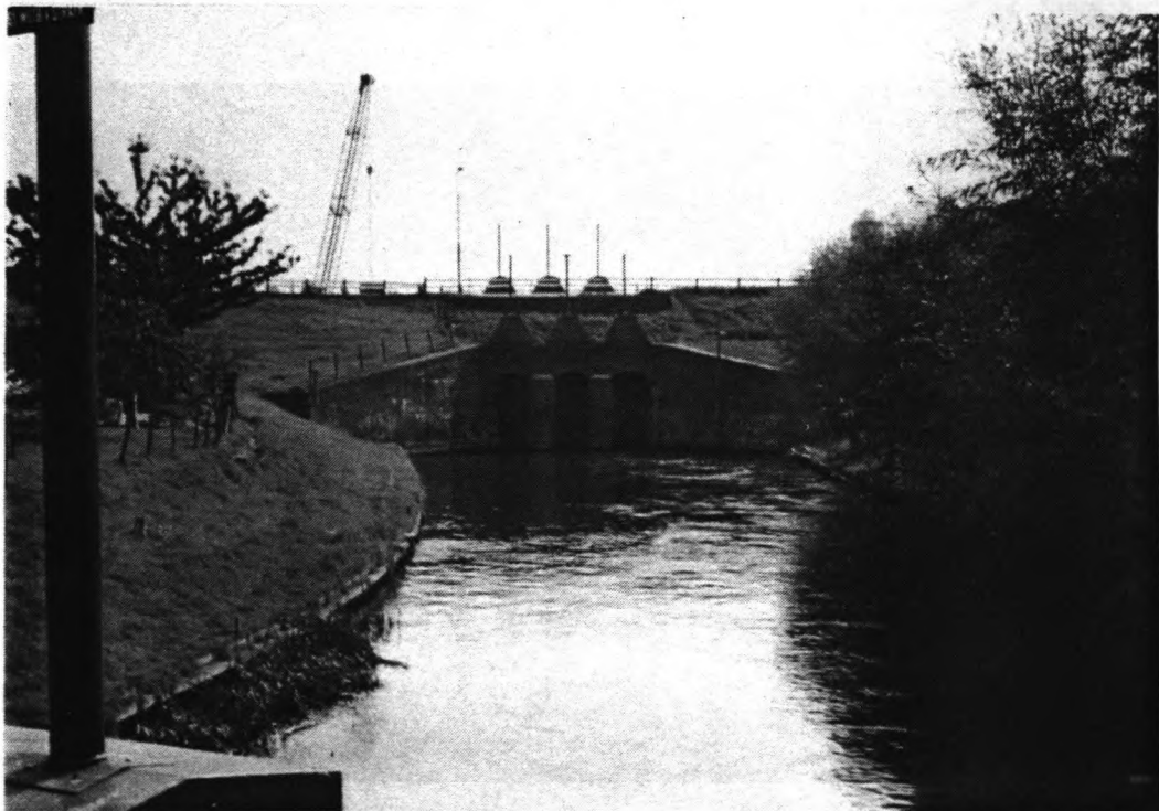
Figuur 4: Foto aanzicht inlaatwerk vanaf kwelkomzijde
