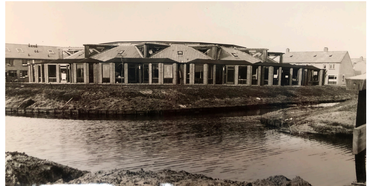
figure 05 - Exterior, 't Ronde - Verhoeven 1979
