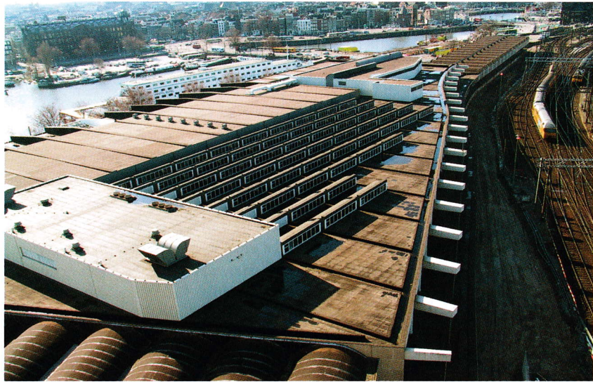
Het dak van het pakketpostgebouw waarop de installatieruimten in 1978, als dozen werden toegevoegd.
