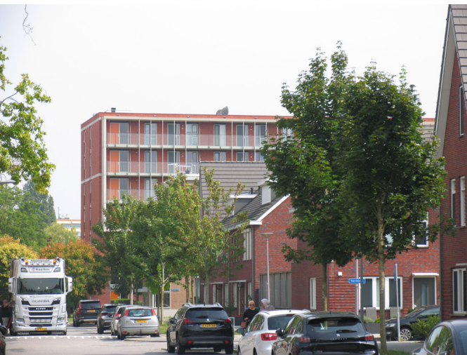
New construction in Zuidwijk.
