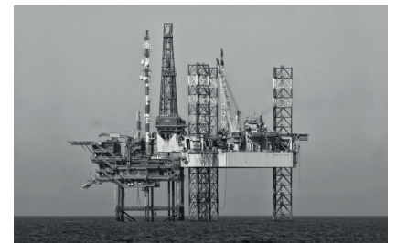
// fig. 03 // Research Site: Platform Q13a-A
