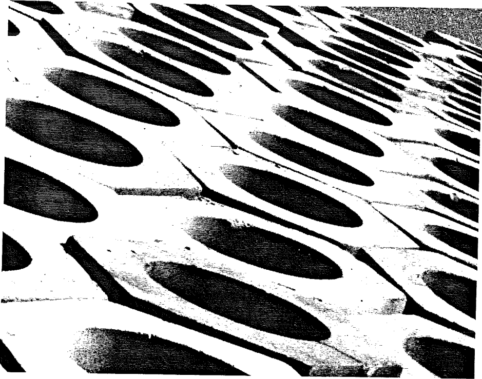
Fig. H2.9. De Seabee geplaatst op de golfbreker
