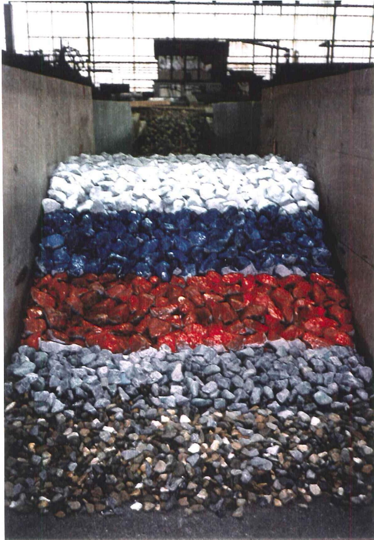
Foto 41 Plaatsing van de breukstenen
