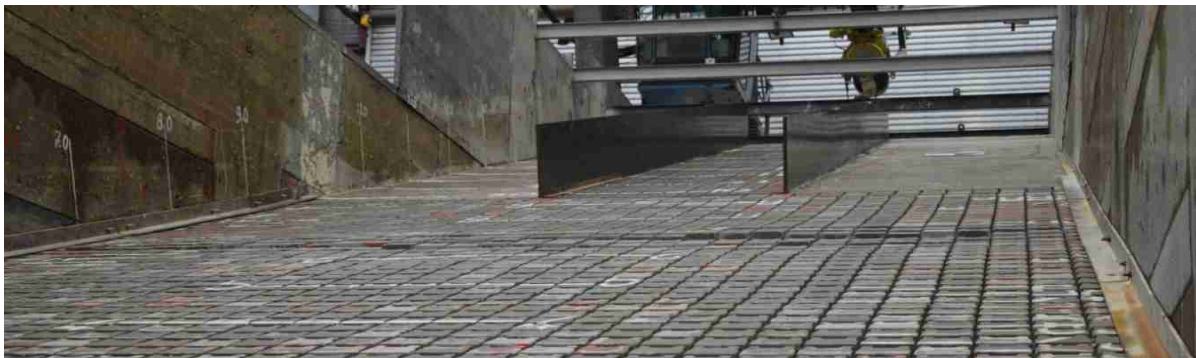
a) vervorming van het talud na proef R13 (serie 3)
