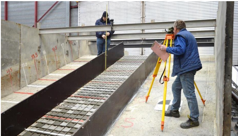
Figuur 3.9 Het inmeten van de lijnen op het talud met een waterpastoestel.
