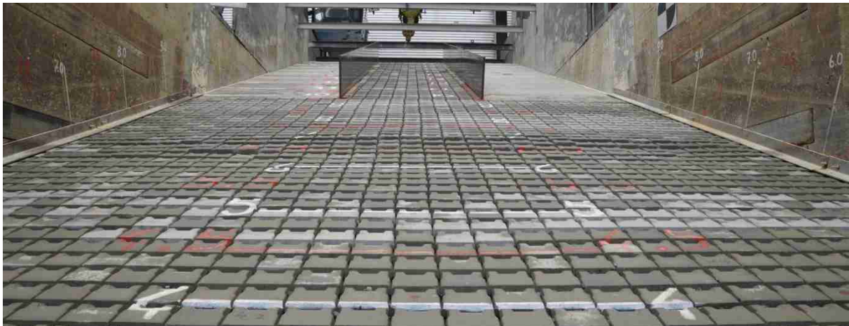
a) vervorming van het talud na proef R04 (serie 2)
