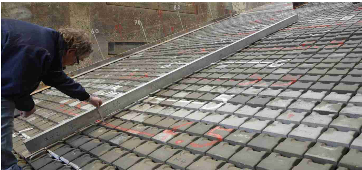
c) vervorming van het talud na proef R04 (serie 2)
