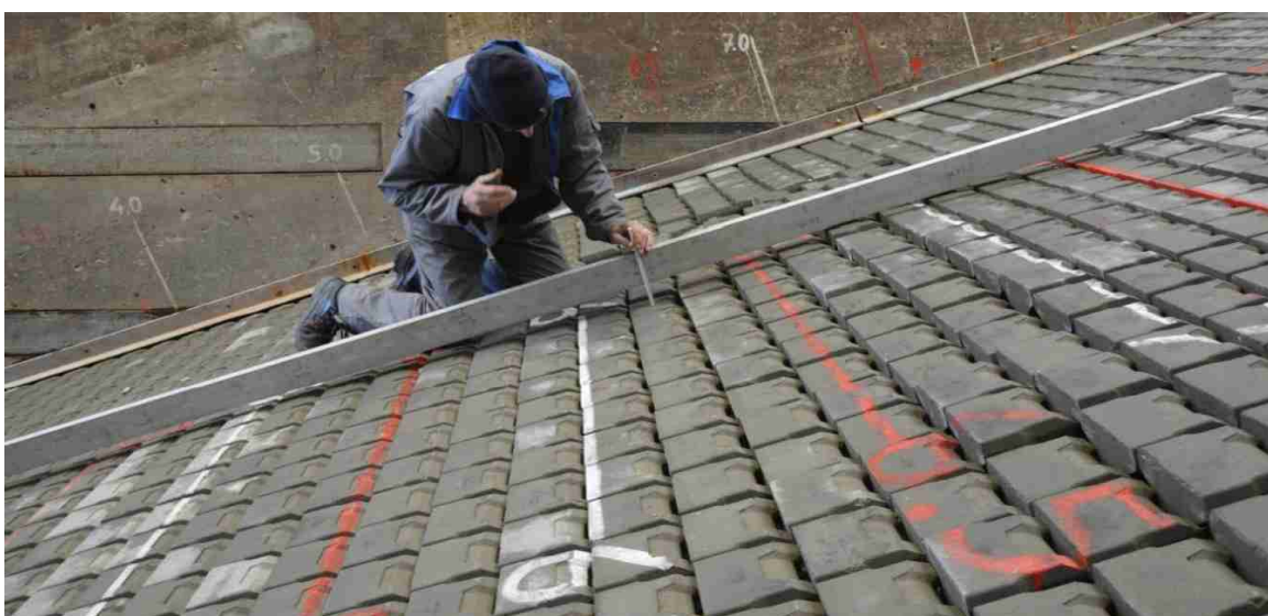
b) schade en vervorming van het talud na proef R05 (serie 2)
