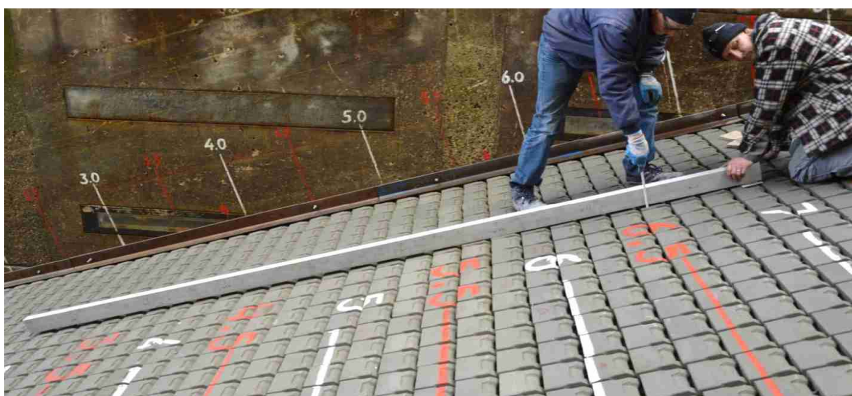
b) lichte vervorming van het talud na proef R01 (serie 1)
