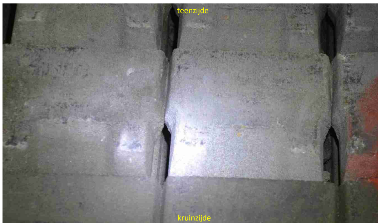
a) in de zwaarst belaste zone van het talud waren ontwateringsgaten, spleten en L-vormige hoeken grotendeels leeggespoeld (proef R01, serie 1)
