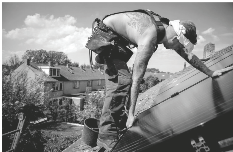
Op een woonhuis worden zonnepanelen geplaatst. Beeld ANP
