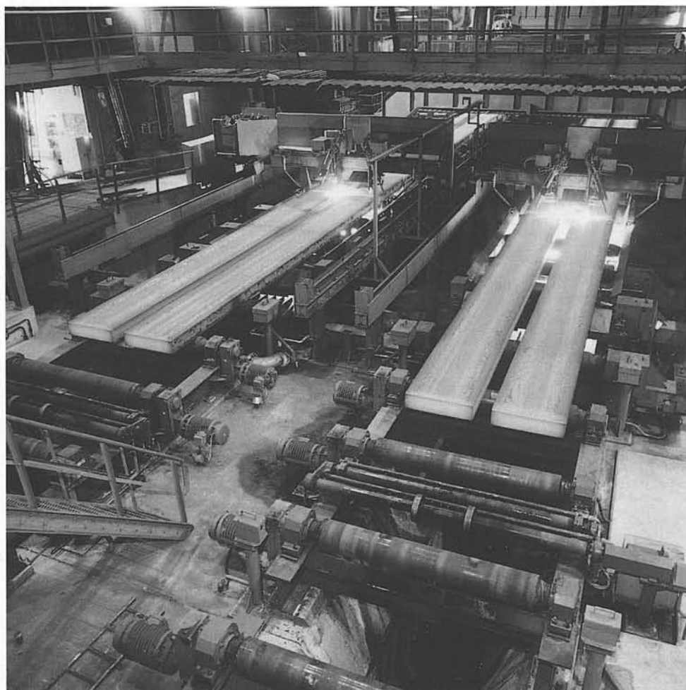
Figuur 5.13 Continu Gietmachine Oxystaalfabriek 2 Koninklijke Hoogovens IJmuiden
