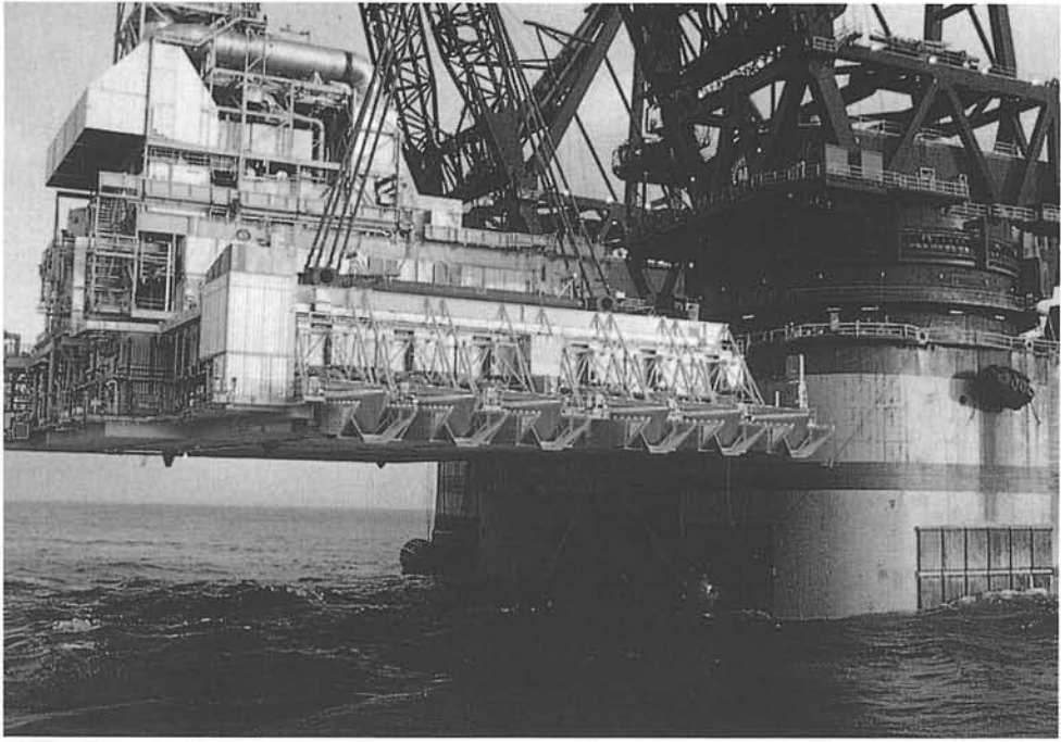
Figuur 3.18 Platform voor plaatsing
