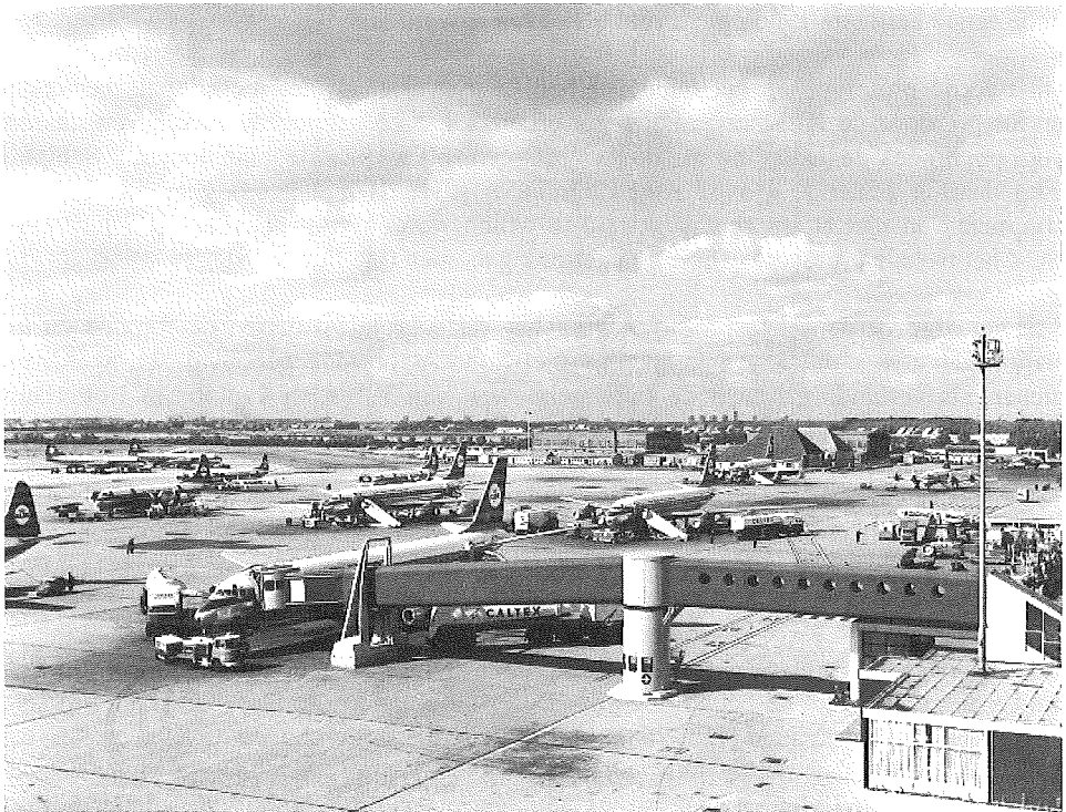
Figuur 18: Tweede prototype Aviobrug zoals dat op 8 juni 1965 op het oude Schiphol officieel in gebruik werd genomen (nog in donkere beschildering).
