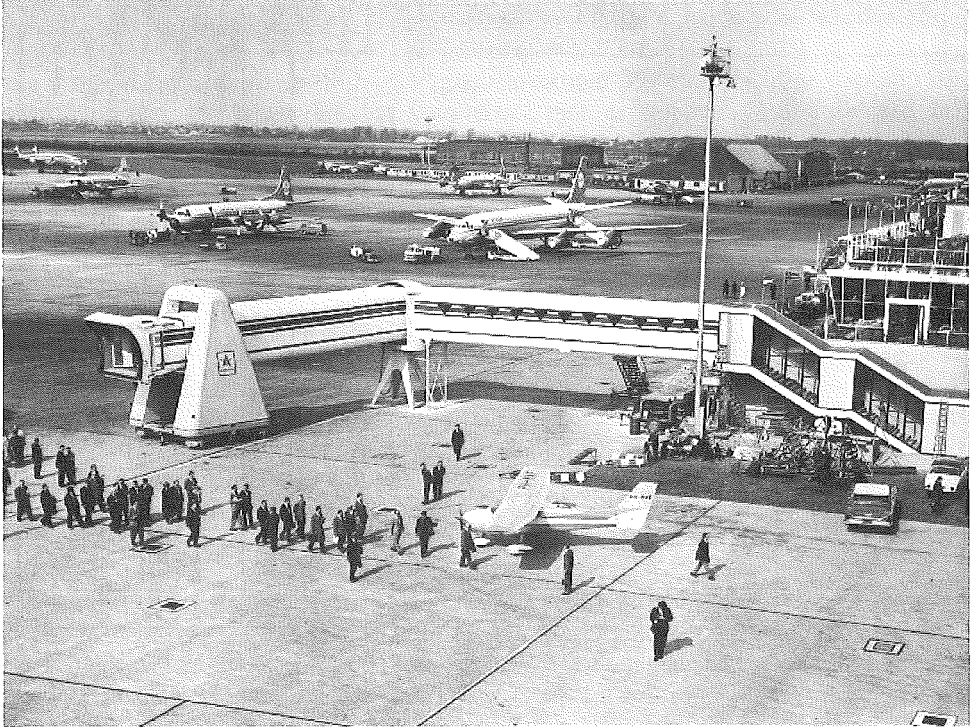
Figuur 15: Het eerste prototype van de Aviobrug dat op maandag 7 augustus 1961 officieel in gebruik werd genomen.
