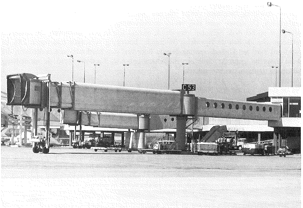
Figuur 24: Verder 'geëvolueerde' Aviobrug met 'minimover' voor zowel de uitschuivende als ook de zijwaartse (roterende) beweging.
