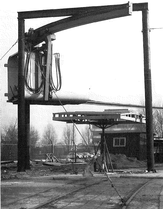
Figuur 21: Dummy van een stuk van de over-the-wing-brug waarmee Aviobridge in februari 1969 in Papendrecht proeven deed.
