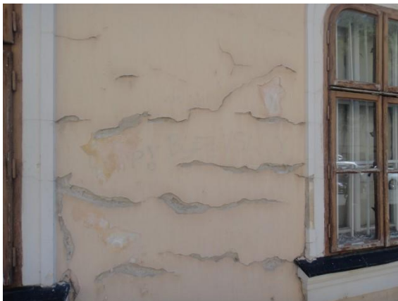
Fig. 7 (vervolg). Voorbeelden van zoutschade. Bovenste rij: alveoli in links Savonnières kalksteen, Place St. Pierre 2, Bar le Duc (2010) en rechts Obernkirchener zandsteen, Nieuwe Badkapel, Scheveningen (2017). Middelste rij: alveoli in mortel, links aan de Laurentiuskerk in Baflo (2004), rechts aan de NH Kerk in Hoorn, Terschelling (2005). Onderste rij: zoutschade aan pleister, Frantiskanske namestie 4, Bratislava (2014).
