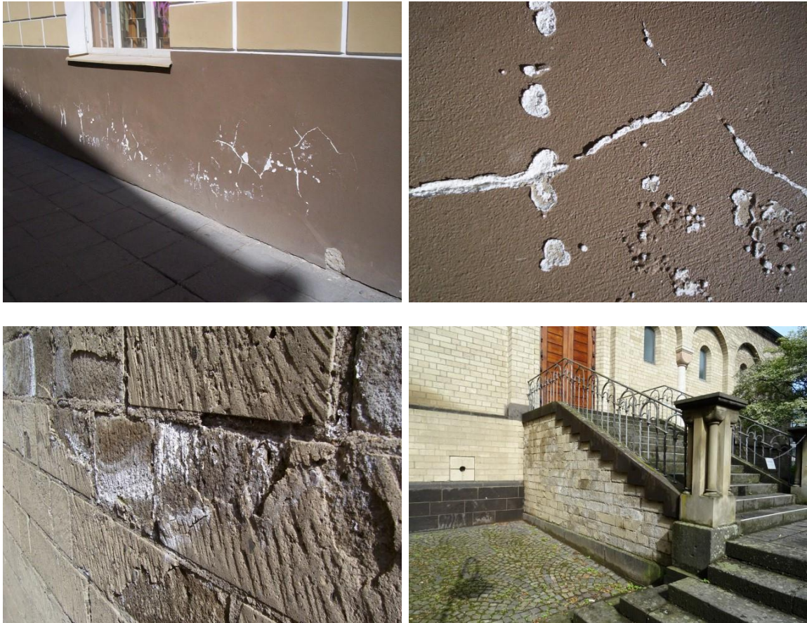
Fig. 7 (vervolg). Voorbeelden van zoutschade. Bovenste rij: zoutschade aan pleister, Suur-Klooster, Tallinn (2005). Onderste rij: Afspringen van Weiberner tuf, St. Maria im Kapitol, Keulen (2009 & 2017).
