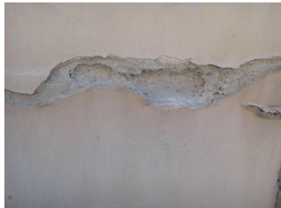
Fig. 7 (vervolg). Voorbeelden van zoutschade. Bovenste rij: alveoli in links Savonnières kalksteen, Place St. Pierre 2, Bar le Duc (2010) en rechts Obernkirchener zandsteen, Nieuwe Badkapel, Scheveningen (2017). Middelste rij: alveoli in mortel, links aan de Laurentiuskerk in Baflo (2004), rechts aan de NH Kerk in Hoorn, Terschelling (2005). Onderste rij: zoutschade aan pleister, Frantiskanske namestie 4, Bratislava (2014).
