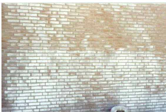
Fig. 5. Vergipsing op metselwerk.
