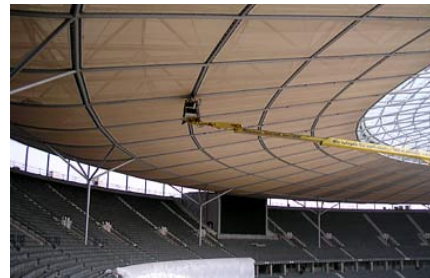
april 2004 afwerking van semi-transparante onderkant van het dak
