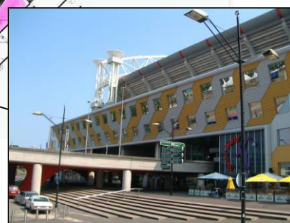
Inzet: bestaande hoofdgebouw
