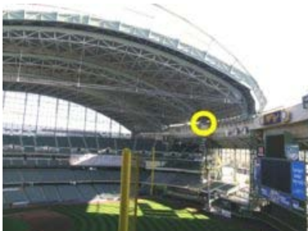
afb. 2.4 Het dak wordt bij het omcirkelde punt opgetild om een onderstel te vervangen
