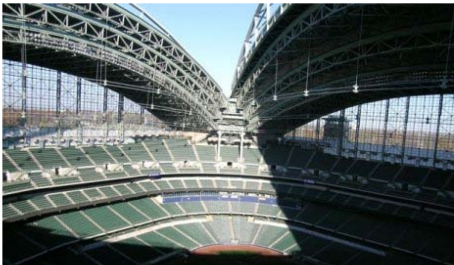
afb. 2.3 Het geopende dak: rechts zijn drie dakpanelen 'opgestapeld', links twee
