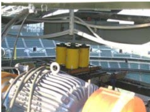
afb. 2.7 In deze lift waren de cilinders in een groep van vier opgesteld. De cilinders zijn voorzien van ronde koppen en rusten op een Teflon-"sandwich" om het zijdelingse bewegen op te vangen.
