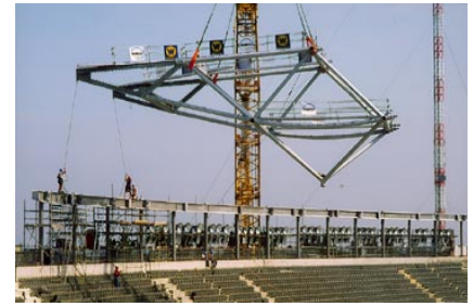
september 2002 plaatsing dakelementen
