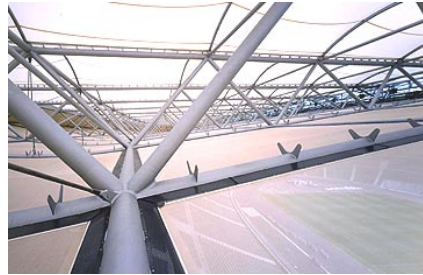
oktober 2003 bevestiging dak
