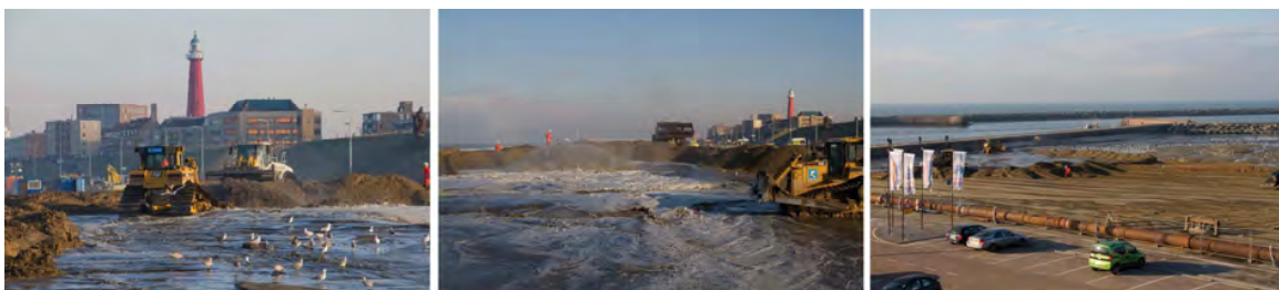
Figuur 3.10 Een strandsuppletie in uitvoering
