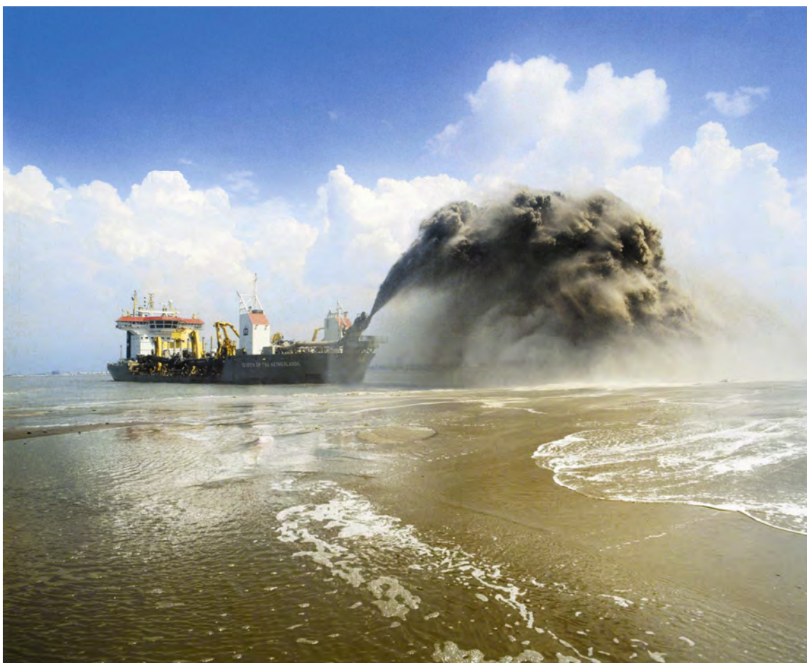
Figuur 4.4 Vooroeversuppleties via het zogenaamde 'rainbowen'
