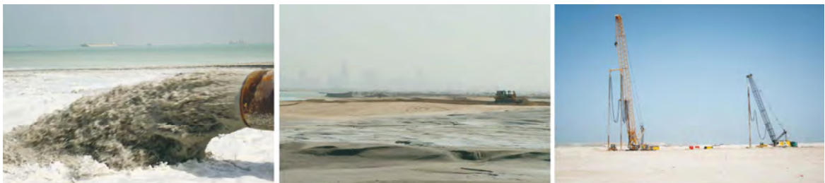
Figuur 3.7 Het proces van landaanwinning begint met het aanvoeren en vervolgens het verdelen en verdichten van zand.
