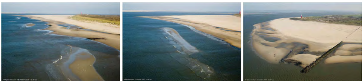
Figuur 5.3 Kustaanwas bij de Eijerlandse dam, Texel (strekdam aangelegd in 1995)
