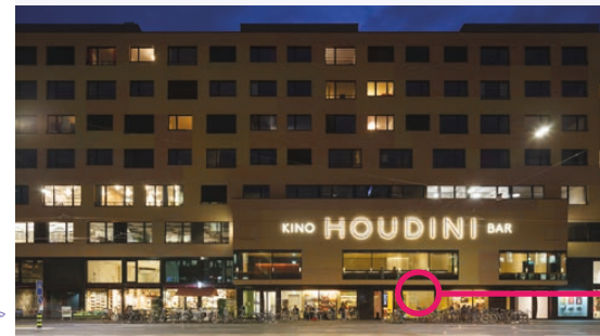
Figure 30. Kalkbreite - Exterior View, Houdini Cinema.
