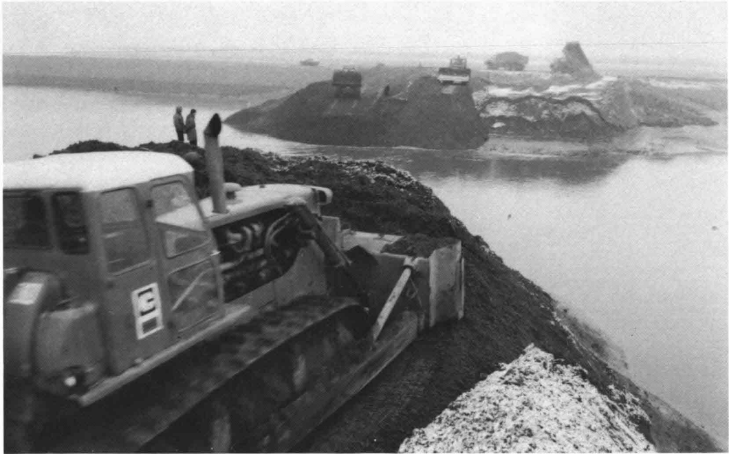
een sluitgat in de laatste fase
