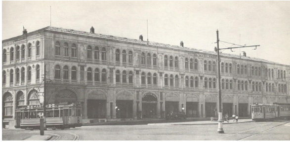
Fig. 4.7 Hotel des Galeries in april 1933. (1933). [Photograph]. In Scheveningen: Uit de Geschiedenis van een Vissersdorp (p. 78).
