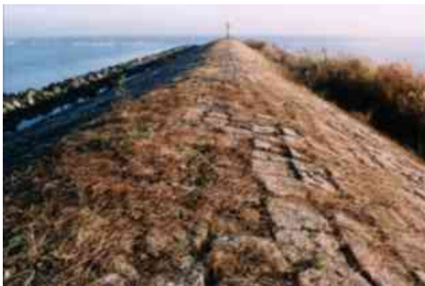
Figuur 1.2, Havendam van Ketelhaven
