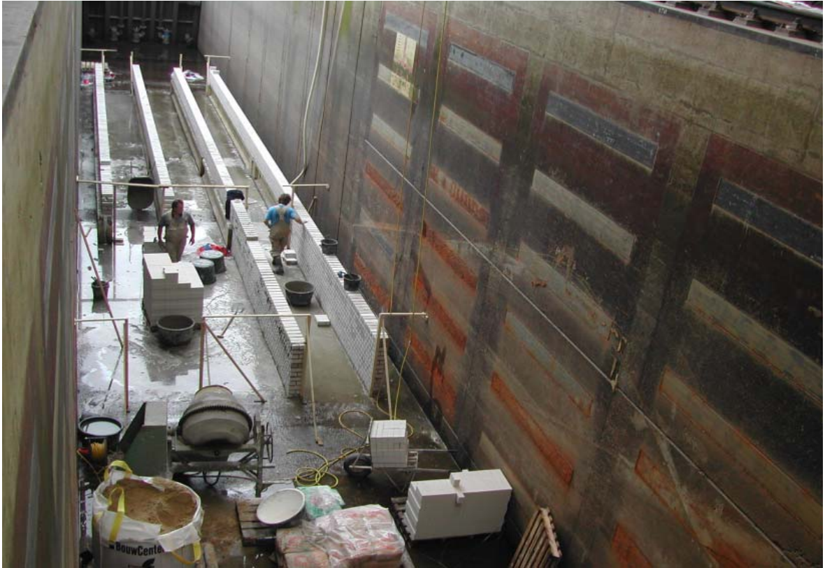
Bouw van ondersteuning tweede vloer
