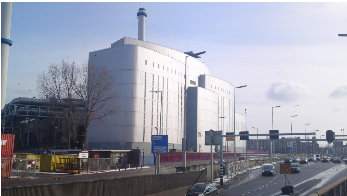
De afvalverbrandingsinstallatie met vooraan de rookgas reiniger, rechtsonder is de drukke Brielselaan te zien die doorloopt in de Maastunnel.
