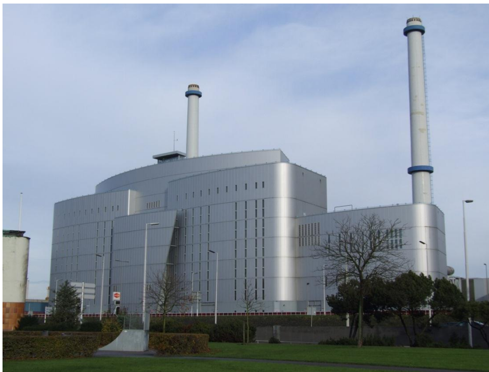
Afb. de rookgasreiniger vanaf het Karel de Stoute park gezien.
