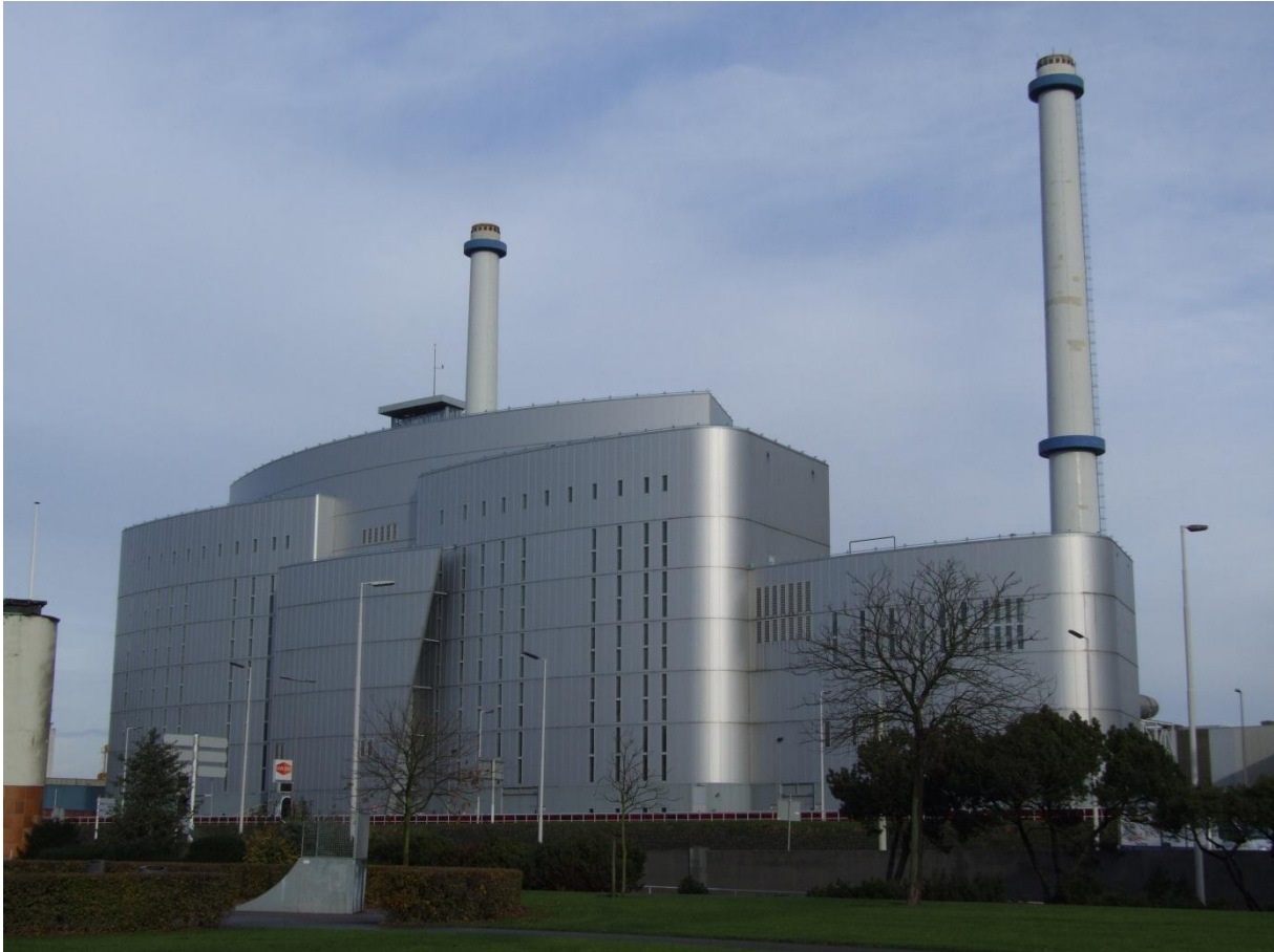
De rookgasreiniger van de AVR ( Afval Verbrandingsinstallatie Rijnmond) aan de Brielselaan.
