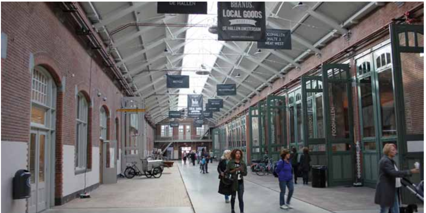
Figuur 16 Entreehal en spanten dakconstructie 5
