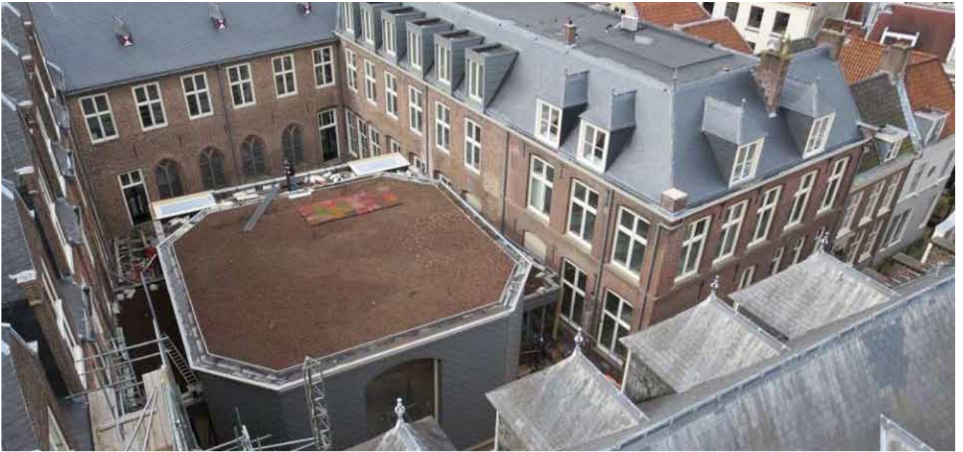
Figuur 41 Het cluster van de zeven historische gebouwen 21
