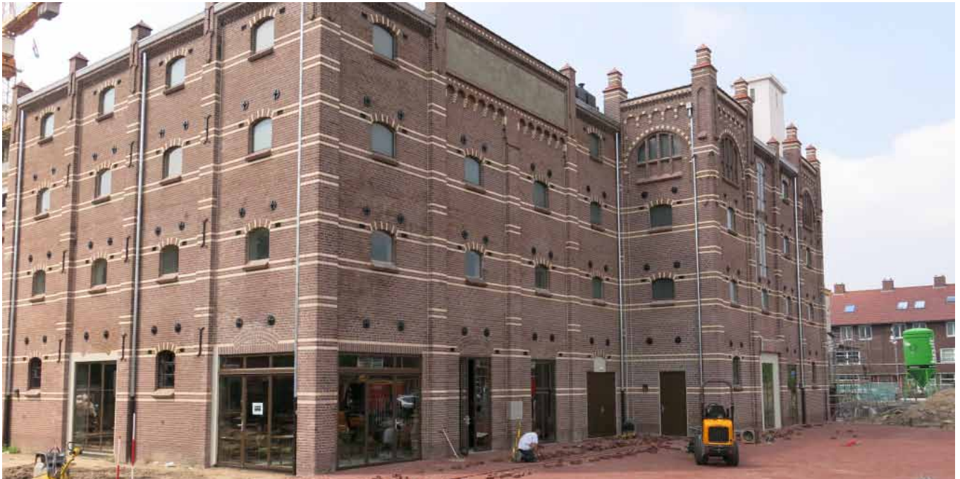
Figuur 25 Fabrieksgebouw Cereolfabriek 11
