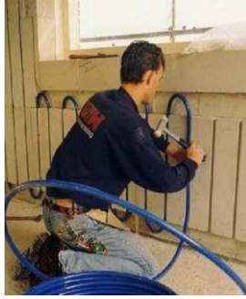
2.5.4,5,6 integration of TABS in walls gezondbinnen.nl
