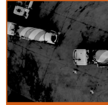
Concrete foundation Unicon København 10 km
