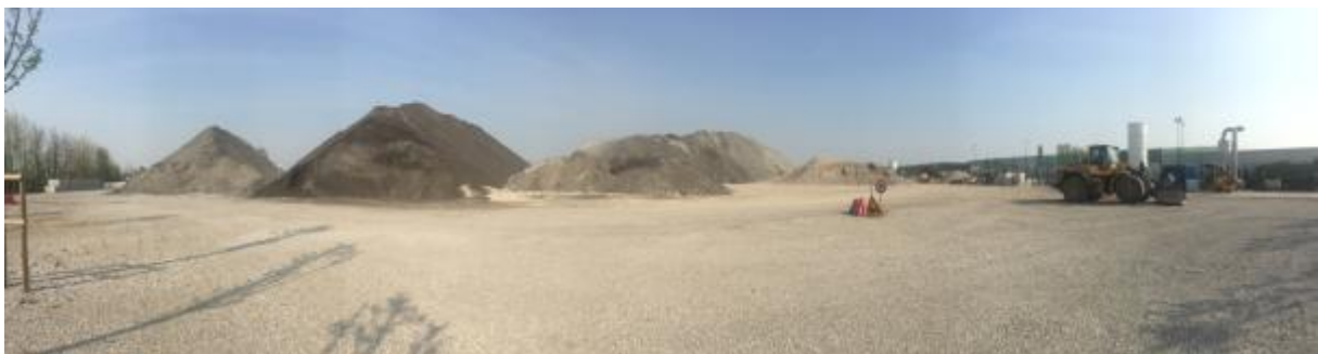
Figura 1 | Impianto di recupero ecologico materiali a Motta di Livenza (TV).
