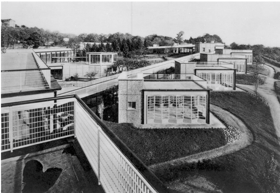
Figuur 5 (De Openluchtschool van Suresnes. Een ontwerp van de Franse architecten Eugène Beaudouin en Marcel Lods uit 1935.) Foto van de inspiratie voor Jos Bedaux.
