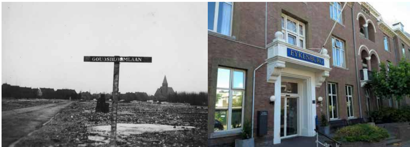
12. De Begoniastraat na de afbraak, bij de kruising met de Goudsbloemlaan. Op de achtergrond de kerk aan de Sportlaan. Dit was het dagelijkse uitzicht van Vrijenhoek na de sloop van huizen in zijn straat ten bate van de Atlantikwall. Foto L. Ketting, 1943. Collectie Haags Gemeentearchief .
