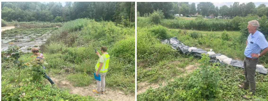
Figuur C1.1: Waterbergingsgebied De Dem met op de linkerfoto rechtsonder de vermoedelijke uitstroomblocatie, op de rechterfoto op de voorgrond de sporen van erosie van dezelfde locatie.
