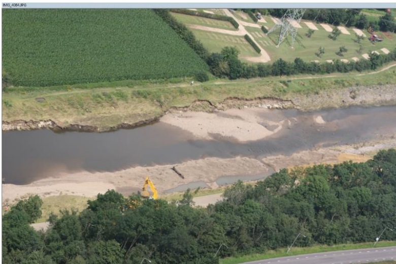
Figuur B.3.6.2: Helikopterfoto herstelwerkzaamheden
