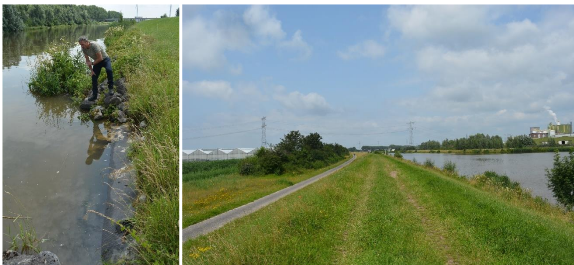
Figuur C.7.1: Buitentalud met deels ontbrekende steenbestorting rond de waterlijn, dijk met binnendijs achtereenvolgens een weg, een smalle diepe sloot, een goederenspoorlijn en een groot kassengebied.
