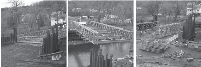
Figuur A5. Demonteren van een Mabey brug
