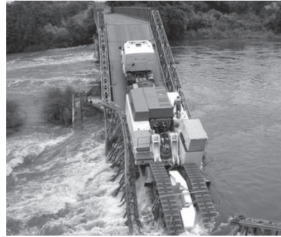
Figuur 1. Ingestorte Mabey brug (Bijlage A)
