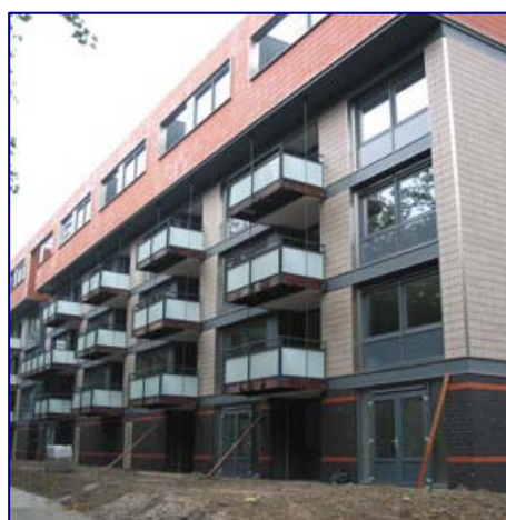
Figuur 12-25 Balkon aan optoplaag
