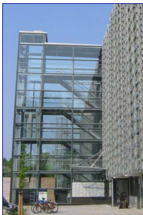
Figuur 11-37 Liftschacht aan buitenzijde
