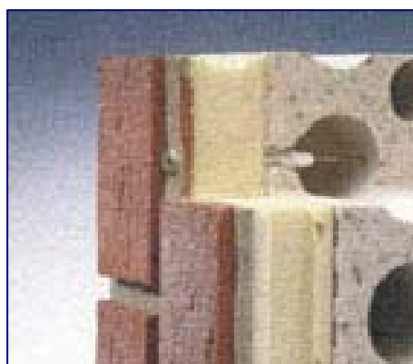
Figuur 12-16 Gebrik systeem
