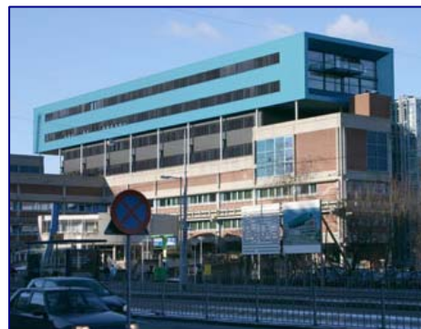
Figuur 13-2 Optoppen van VU medisch centrum met staalconstructie
