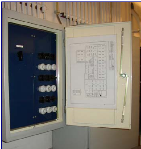
Figuur 0-2 Stoppenkasten en hoogspanningsruimte in de kelder
