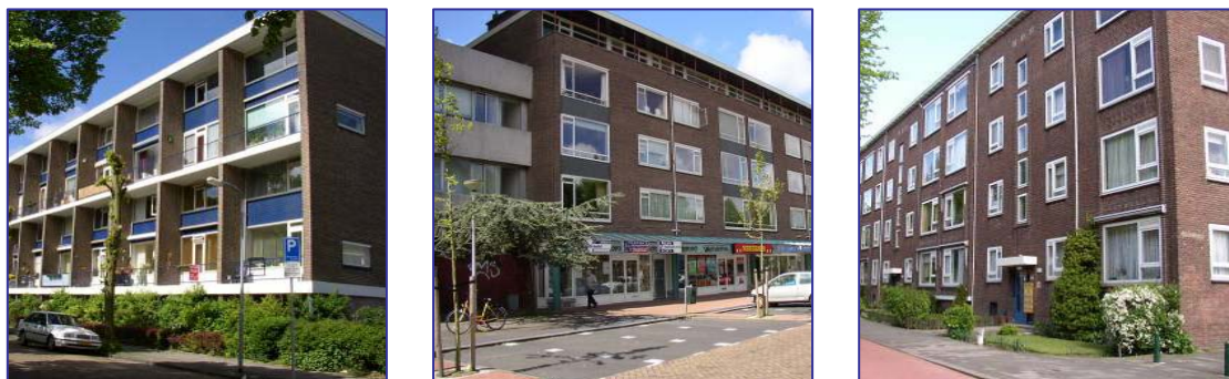
Figuur 5-4 v.l.n.r.; Maisonnettewoningen aan J.H.A. Schaperlaan, woningen boven winkels en portiekwoningen aan de Huis te Landelaan
