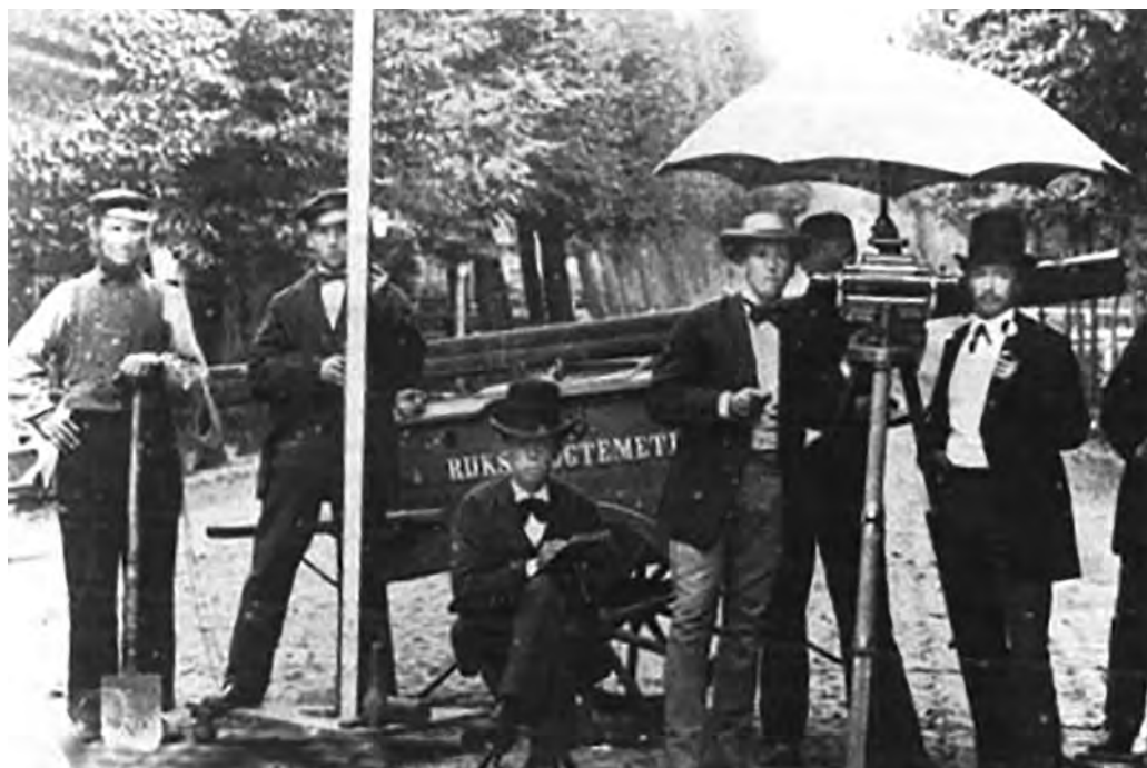
Figuur 1 | Cornelis Lely, met witte hoed, en Caminada waterpasinstrument, als jong ingenieur bij de Eerste Nauwkeurigheids-waterpassing, of Rijks-Hoogtemeting, in de jaren zeventig van de 19 e eeuw.
