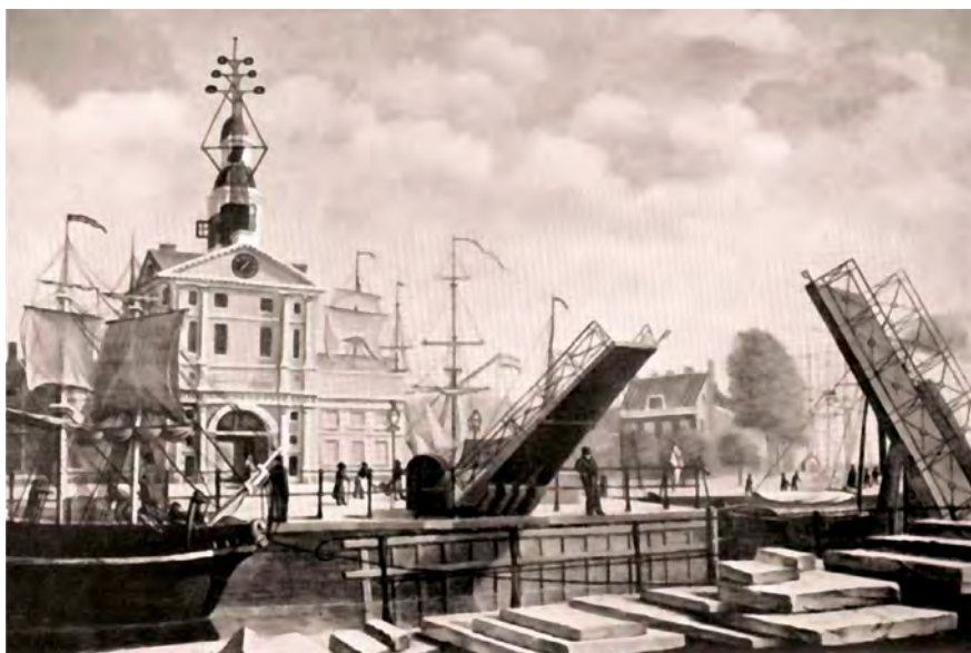
Figuur 2 | De optische telegraaf van Lipkens op de Wittepoort, Rotterdam 1835.
