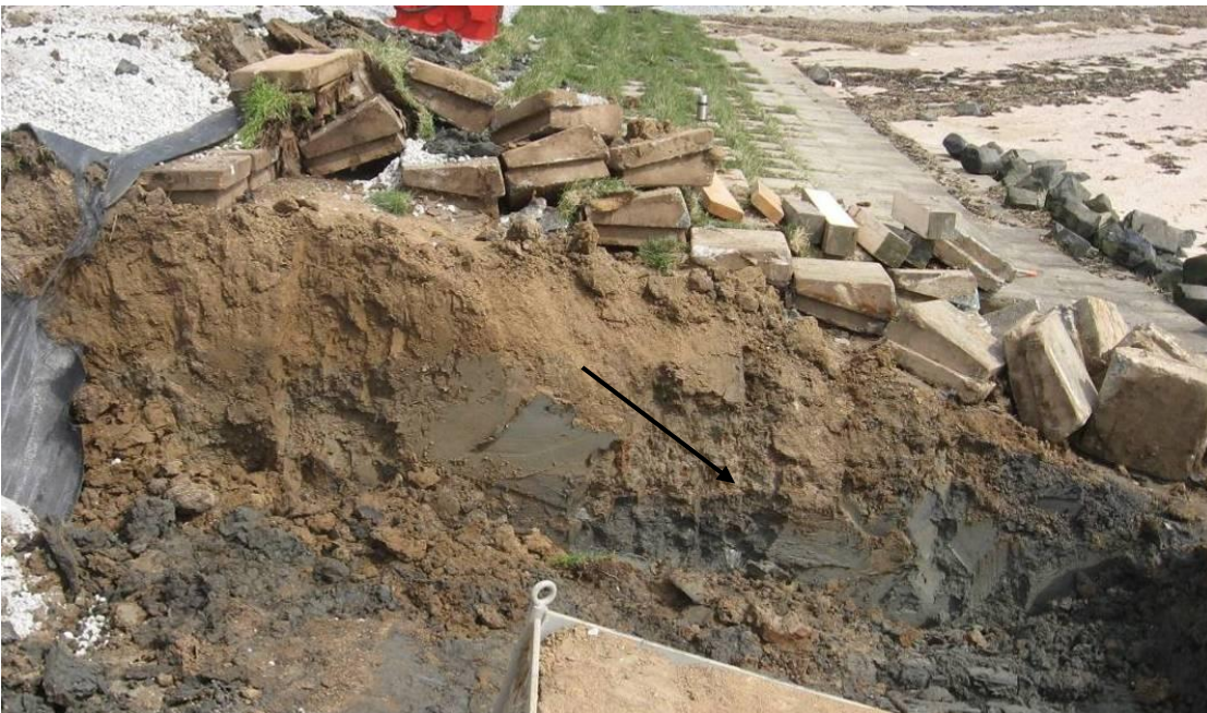
Figuur 6.8 De grond die bijna permanent verzadigd is, tot enige decimeters boven gemiddeld hoogwaterniveau, is grijs en zwart door de reducerende omstandigheden in die zone. Deze gereduceerde zone heeft een bijna horizontale bovenbegrenzing in de foto (zie pijl, door het vergraven lijkt de grens minder scherp dan deze is).
