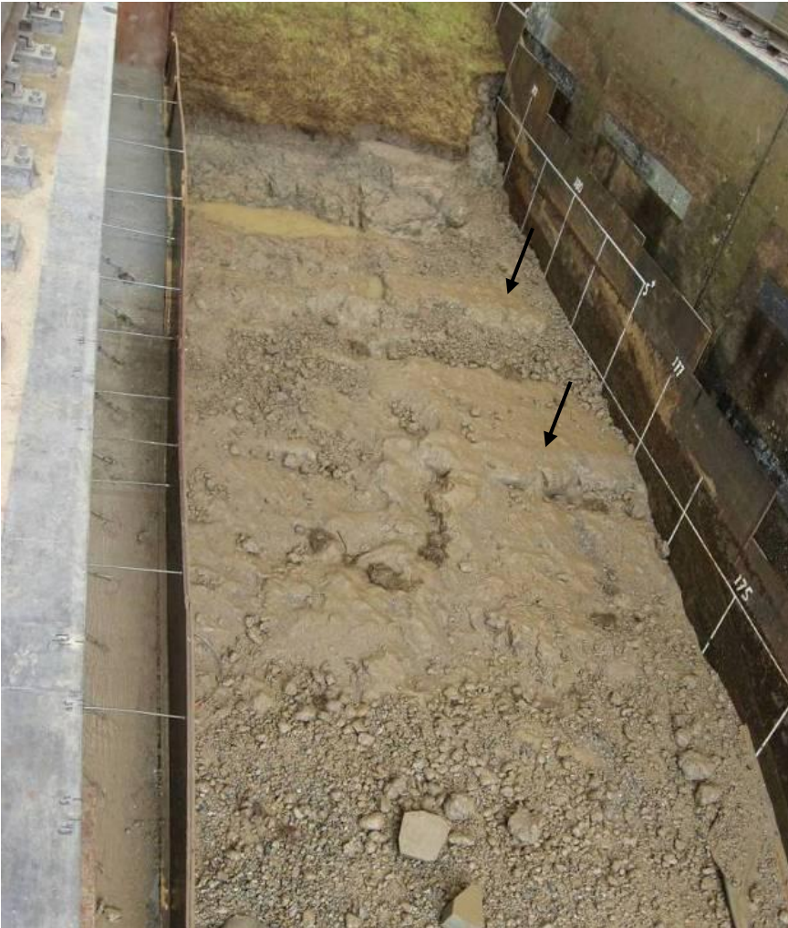
Figuur 6.14 Overzicht van de schade na 1 uur 50 minuten. De ligging van de subhorizontale scheiding tussen de bovenlaag en onderlaag van de klei zoals die te herkennen was in de kleilaag van het talud bij Oosterlande, is goed te zien voor de verschillende aangetaste kleiblokken in de modelopstelling (de pijlen in de foto geven het scheidingsvlak aan voor 2 blokken,). De ontgroning betreft vooral het terugschrijden van de klif in de bovenlaag in dit stadium van de proef.
