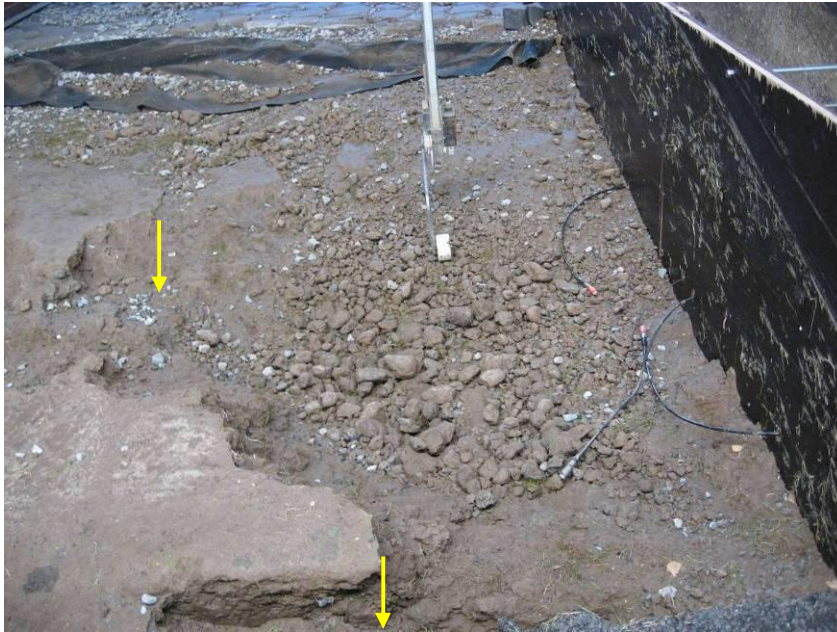
Figuur 6.12 Schade aan het kleioppervlak na minder dan 0,36 uur belasting. Poriewaterdrukopnemers van 0,1 m diepte zijn vrijgekomen. De laag met een fijne bodemstructuur, tot ongeveer 0,3 m diepte (zie pijlen), is plaatselijk al geheel verdwenen. Rechts van het midden is het loopwiel voor het opmeten van het taludprofiel.
