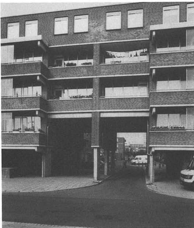
Doorgang onder woningen Onderdoorgang tussen de openbare straat en het semi-openbare binnenterrein. De ruime dimensionering en overzichtelijkheid voorkomen de vaak met smalle, donkere onderdoorgangen geassocieerde onveiligheidsgevoelens. (Den Haag, Bezuidenhout-West).
