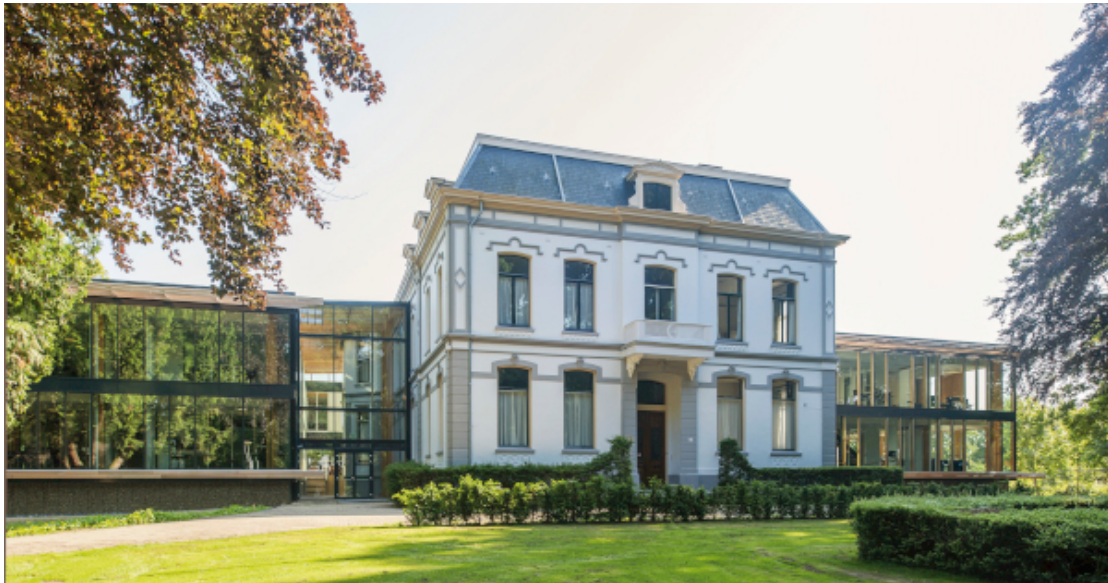
Gemeentehuis Brummen, gebouw als grondstoffendepot (Van Geffen, 2013)
