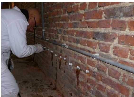
Fig. 2. Applicatie van chemische injectie tegen optrekkend vocht.
