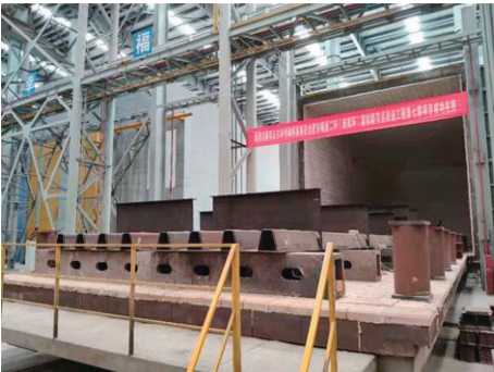
图 5 钢桥面板单元退火处理
